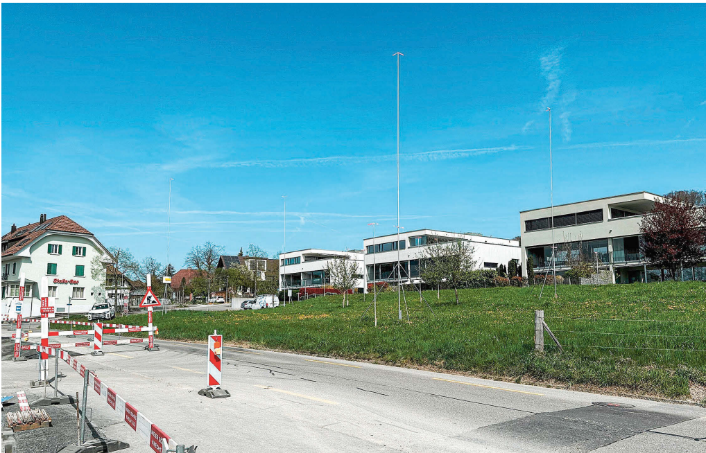
Bauprofile bei der Münzenthalstrasse
