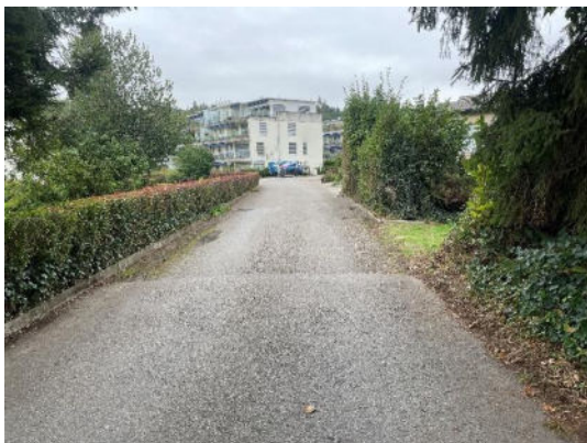
Abbildung 2: Zustand Cholerweg Nord
