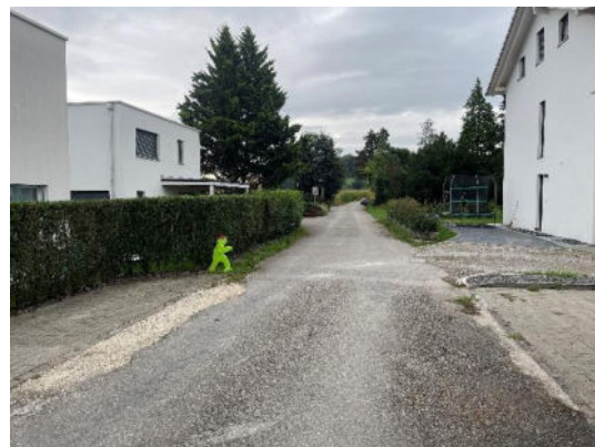
Abbildung 3: Zustand Cholerweg Süd
