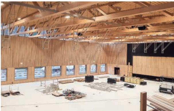
Die Bühne erstmals abgetrennt von der Halle mit den zehn Wandelementen. Jedes dieser Elemente ist 1,2 m breit, 4,3 m hoch, etwa 14 cm dick und rund 300 kg schwer. Auf der Bühnenseite sorgen die Spiegel für ein grosszügiges Raumgefühl. Am Boden und an der Decke lassen sich die fest montierten Turngeräte erkennen.
